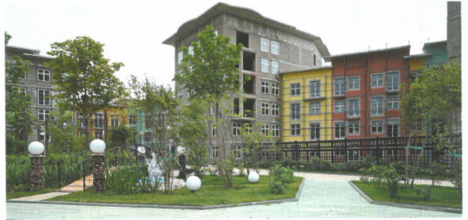
Ход строительства, октябрь 2015 г.
