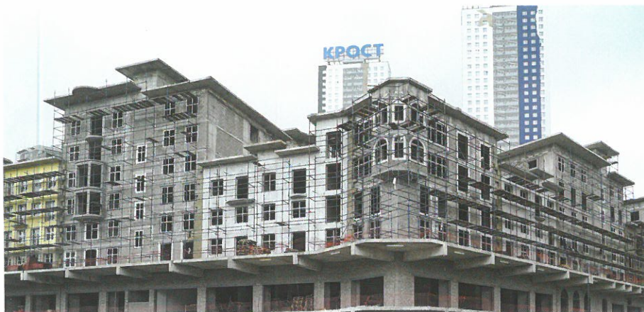
Ход строительства, октябрь 2015 г.
